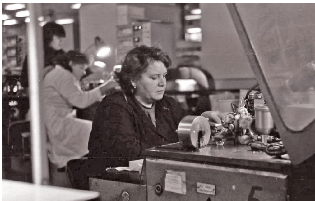
Пайка выводов конденсаторов КМ на полуавтомате
