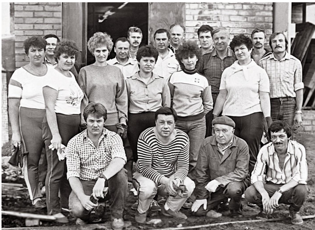
1989 г. На строительстве теплиц
