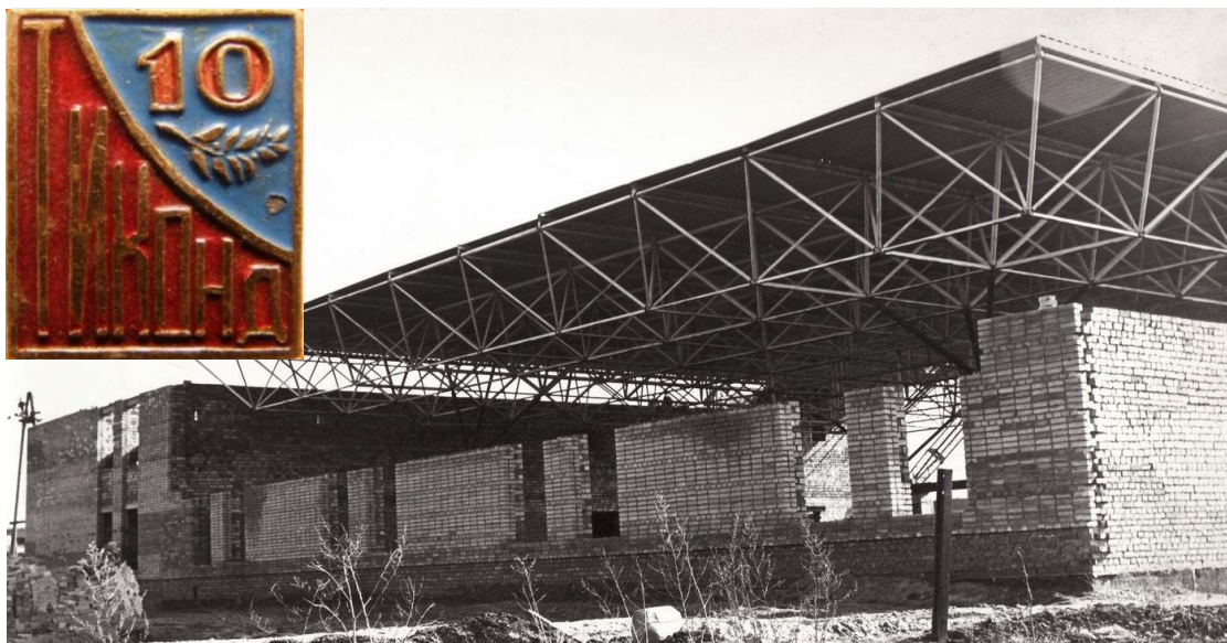
На снимке - строительство связки модулей 2х1000
