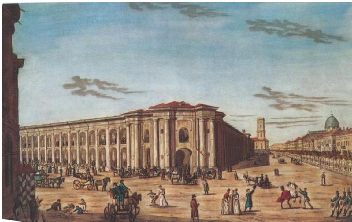
Гостиный двор в Санкт-Петербурге
